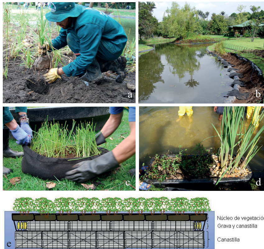
Figura 4. a) Técnica de siembra directa. b) Técnica de cojín. c) Técnica de tanques. d) Técnica de tina. e) Técnica tanques, esquema de canastillas y vegetación.
