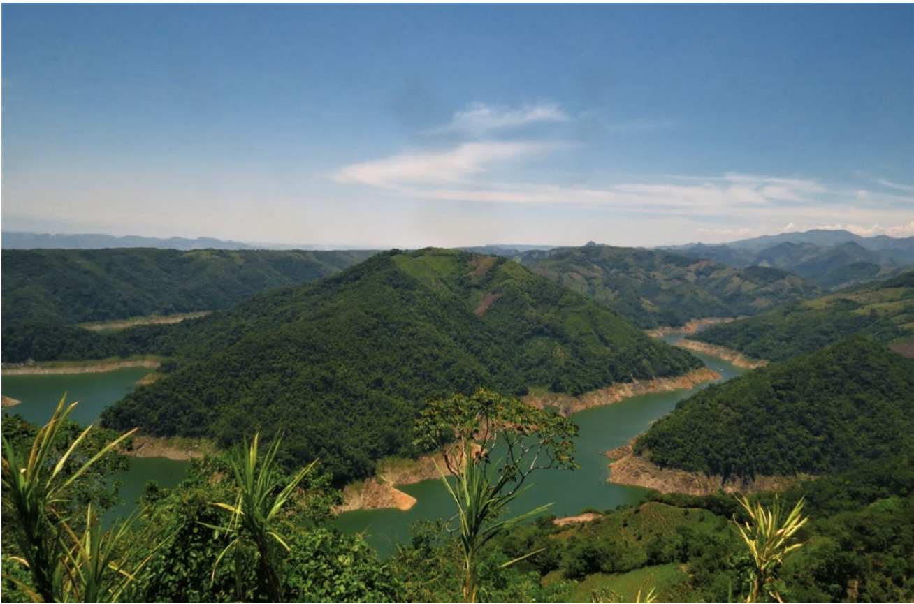
Figura 2. Panorámica del embalse Amaní que abastece la Central Hidroeléctrica Miel I, Caldas, Colombia, con vista en dirección sur. A la derecha se aprecia el curso del río Moro y a la izquierda una parte del río la Miel. Nótese la configuración del paisaje resaltando los fragmentos de bosque remanentes. Fotografía: Julián Andrés Rojas.
